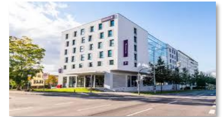
Premier Inn Hotel, Stuttgart (D)
