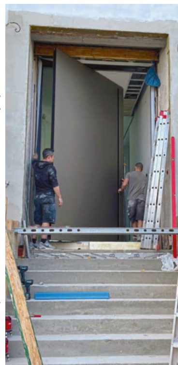
/ Pivot-Türen lassen sich mit Türblattgewichten von bis zu 500 kg realisieren.
