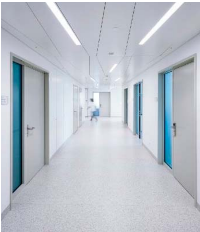
Bei Türen in Patientenzimmern beträgt die lichte Durchgangsbreite bei normalen Patientenbetten 125 und 140 cm bei Schwerlastbetten.
