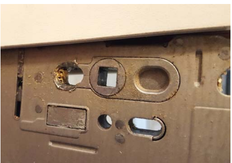
/ Angebohrtes Schloss. Vor den Beschlagbohrungen sollen Schlösser rausgebaut werden.
